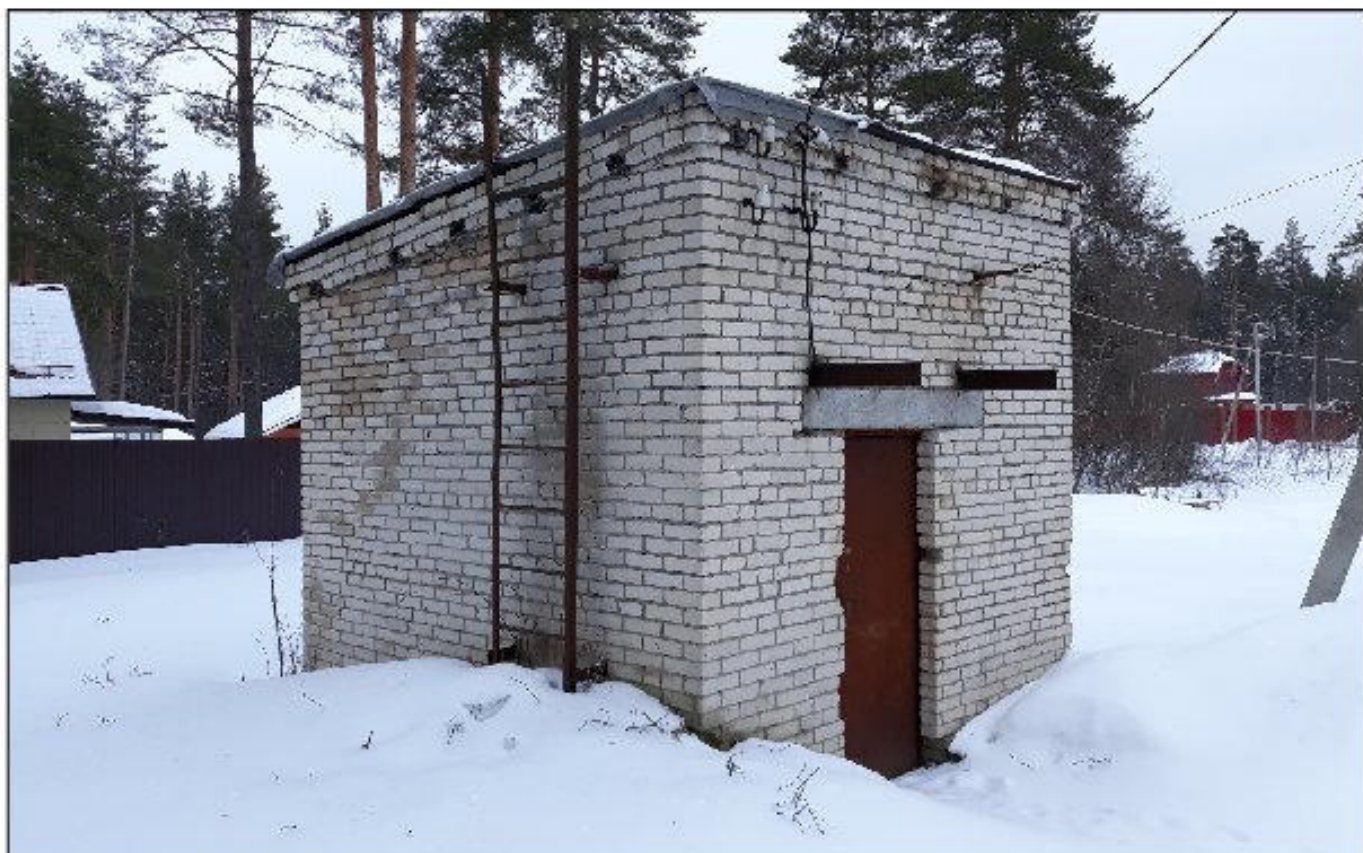
Рисунок ВС-1.7 – Здание скважины в д. Светлое
